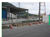
工場周辺の擁壁
