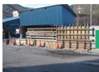
木材置場の擁壁
